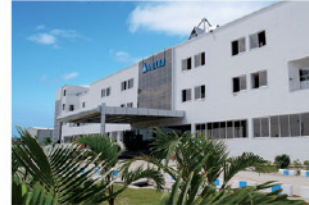
Завод в г. Рудрапур
